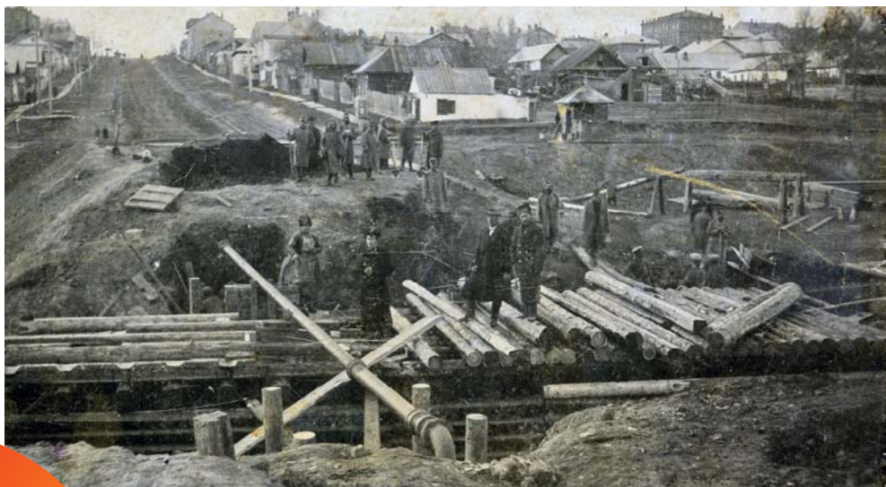
Прокладка водопроводных труб на углу современного Уссурийского бульвара и улицы Дзержинского, 1906 год
