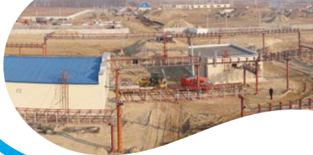
Завершение строительства первого пускового комплекса и насосной станции 2-го подъема
