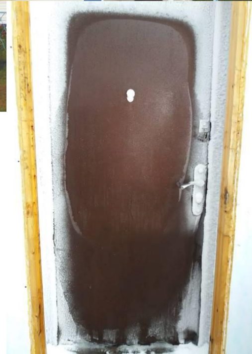
промерзание дверных проемов
