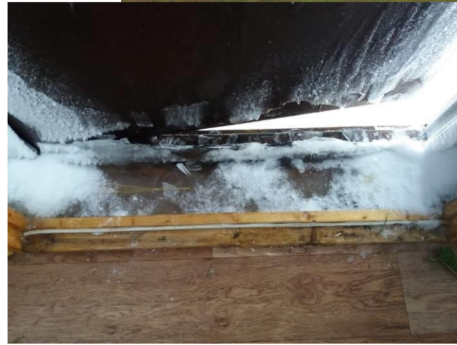
промерзание дверных проемов
