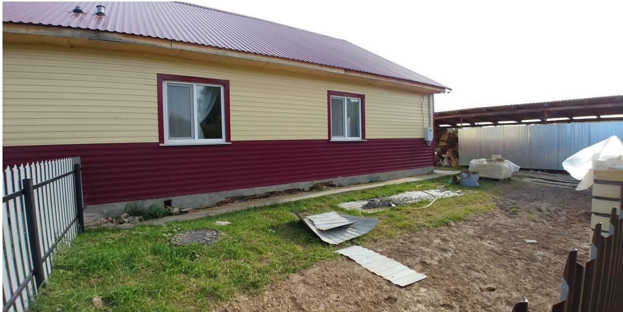
Наружный слой фундамента частично отвалился
