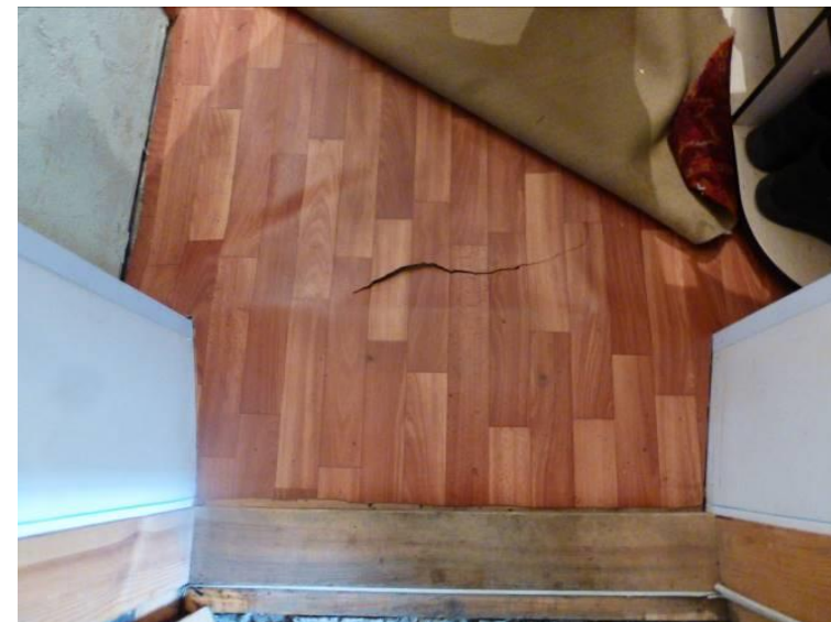
деформация пола, местами гниение
