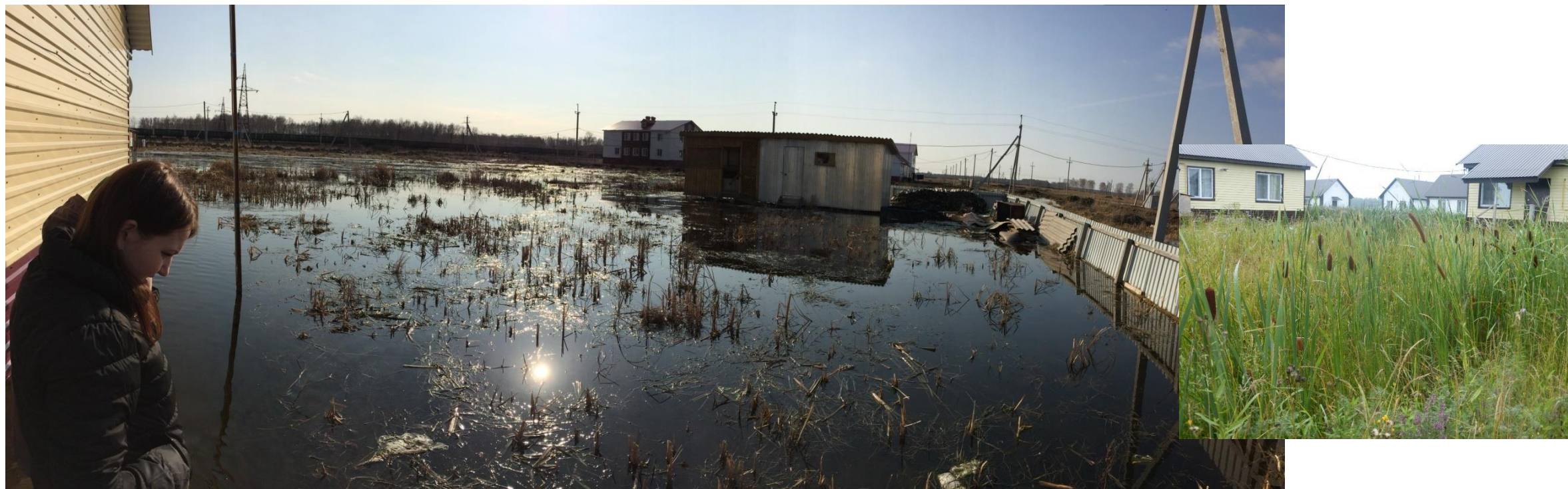
Ежегодное затопление дома по ул. Западная, 19 (Любинский район) , в период весна-лето. 2014-2018гг. В 2013 году введен в эксплуатацию.
