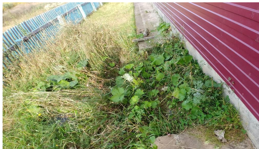
разрушение отмостки, зарастание травой
