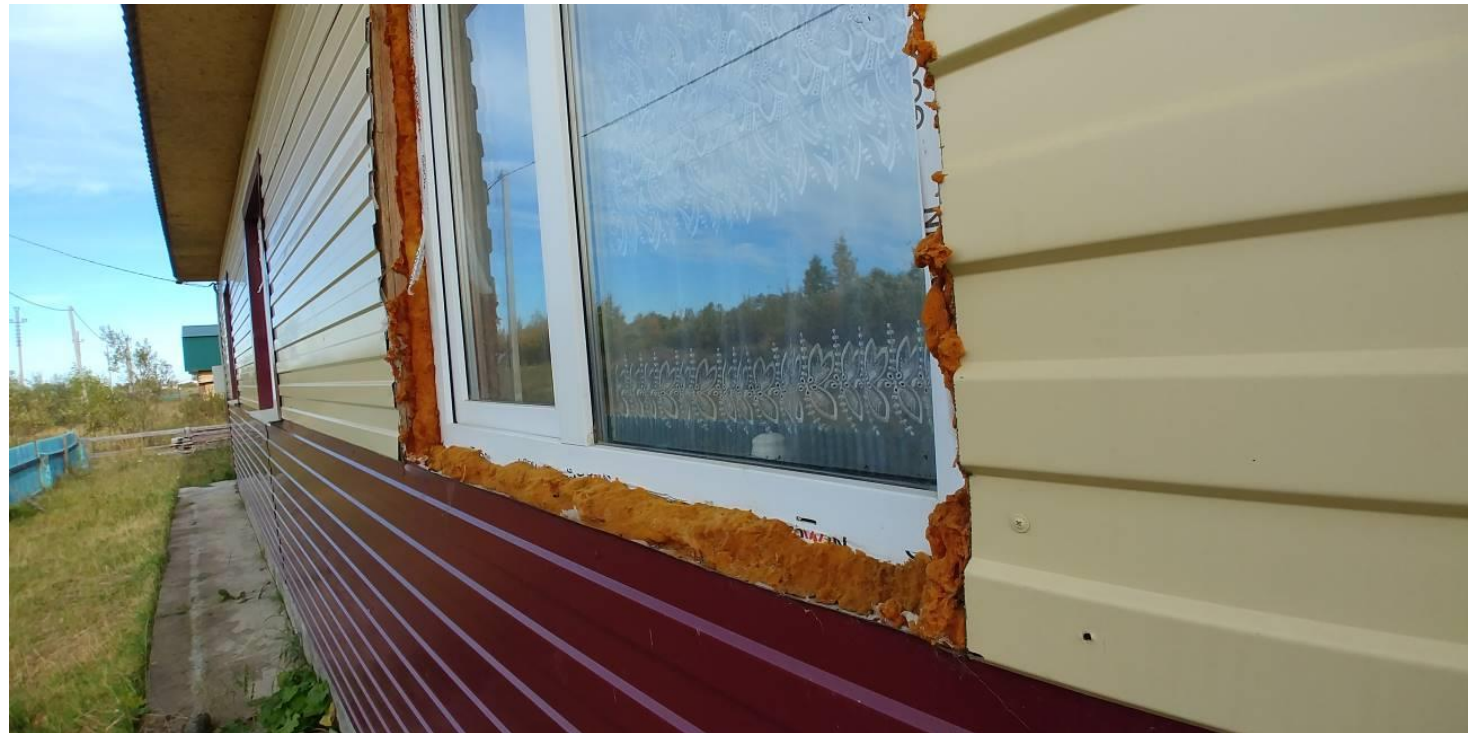
отсутствие отделки оконных проемов
