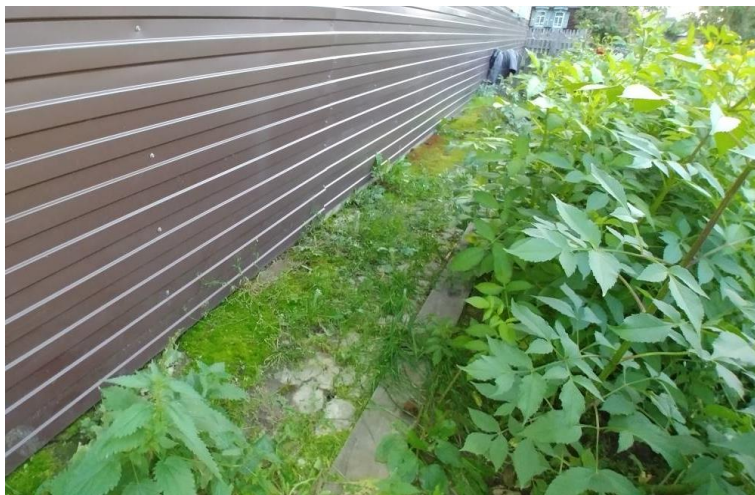
разрушение отмостки, зарастание травой
