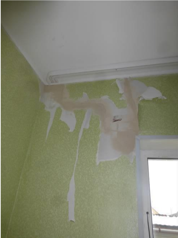
трещины в стене (р-н. Оконешниковский, с. Любимовка, ул. Коммунистическая, д. 16, к. а.)
