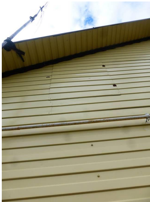
Вход на чердак отсутствует, за сайдингом нет дверки
