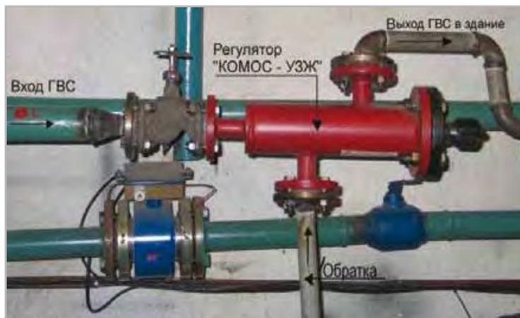
► Монтируется на подающем трубопроводе ГВС под любым углом к вертикали.
