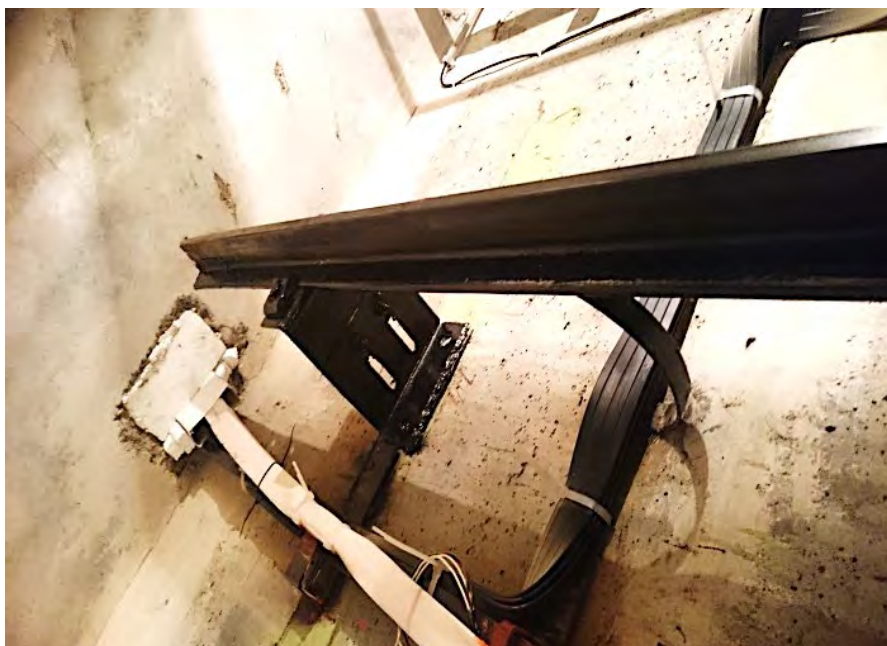
Рисунок 53 –доработка кронштейна крепления направляющей
