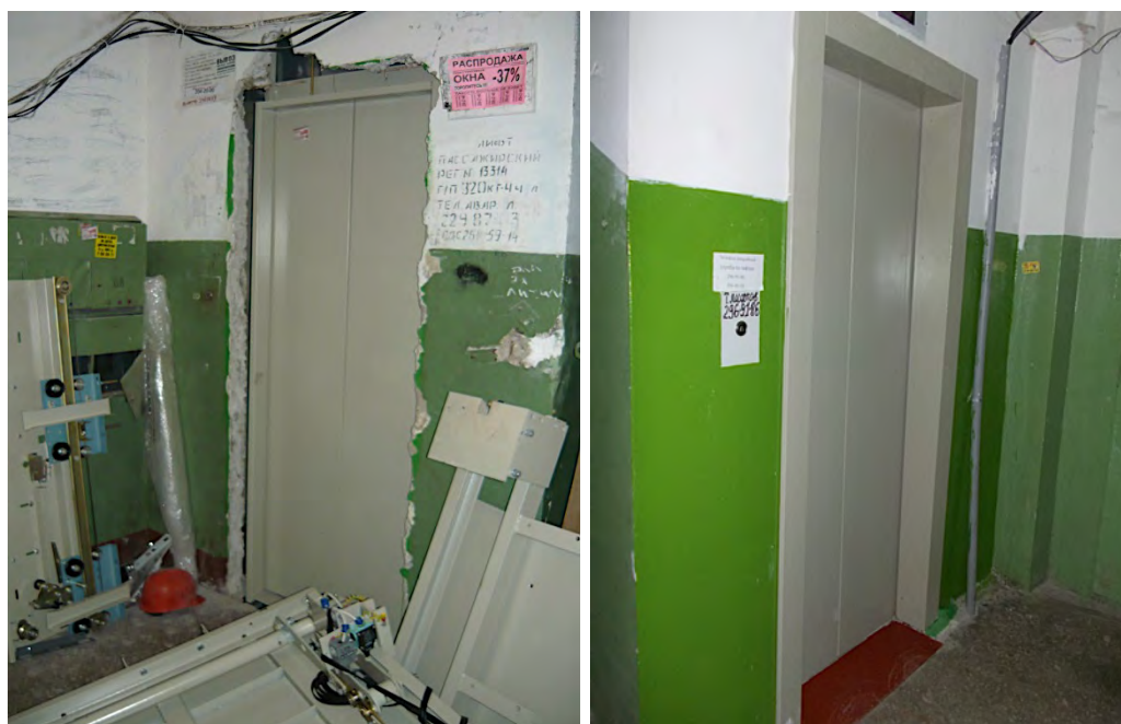
Рисунок 48 – замена и монтаж входных групп лифта
