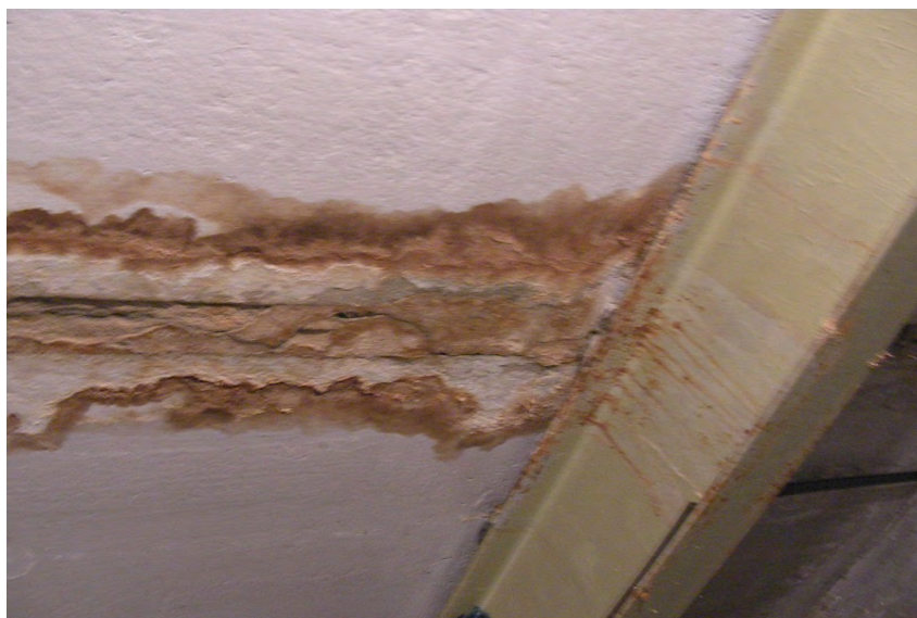
Рисунок 55 – наличие течи в машинном помещении
