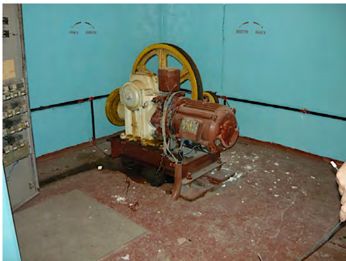
Рисунок 45 – электродвигатель главного привода до замены
