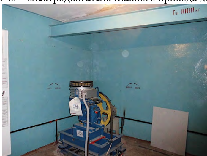
Рисунок 46 – электродвигатель главного привода после замены
