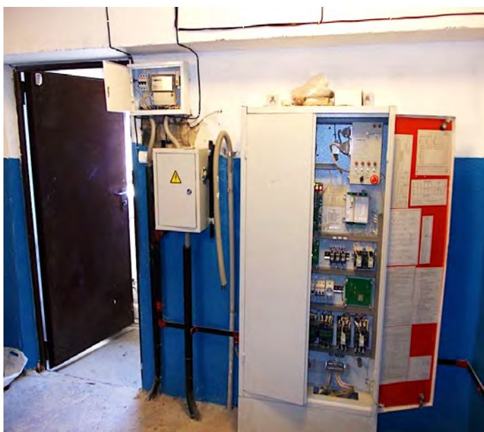
Рисунок 50 – шкаф управления после замены
