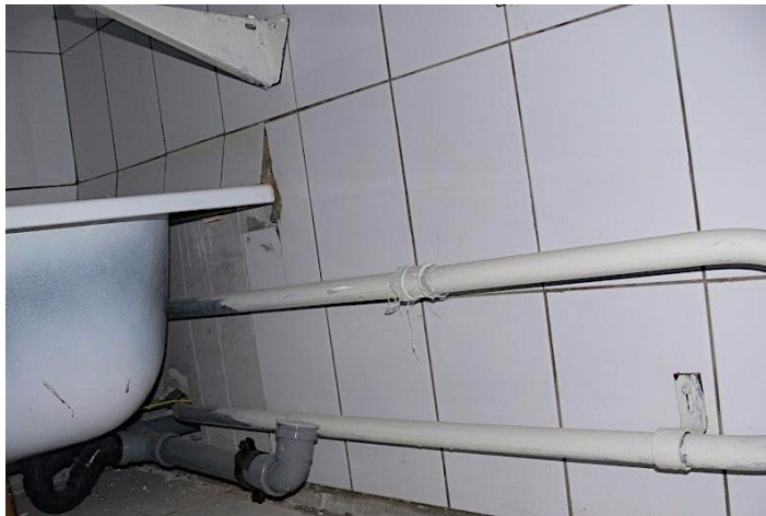
Открытый монтаж соединений
