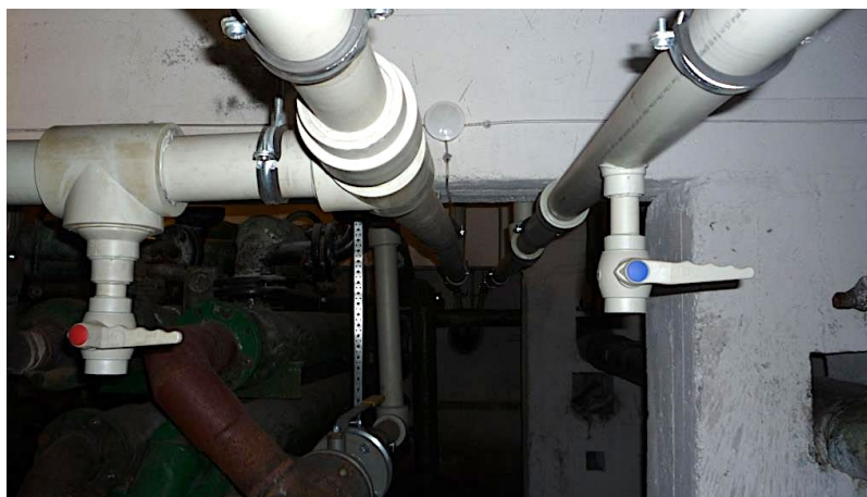
Система розлива системы ХВС и ГВС
