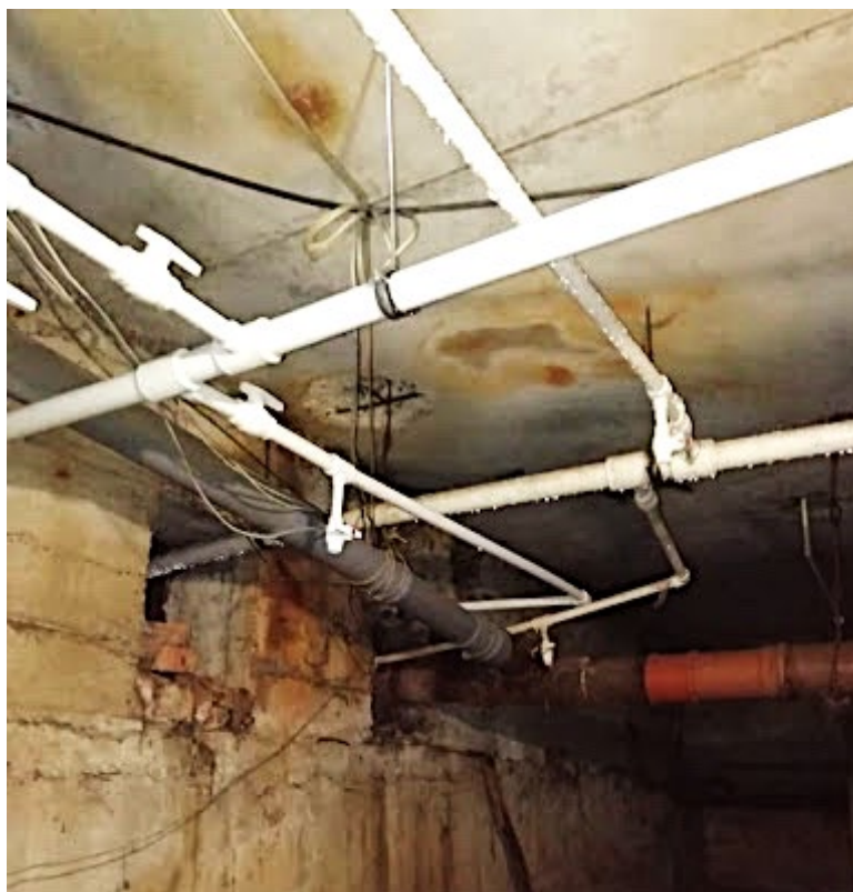
Разводка системы горячего водоснабжения
