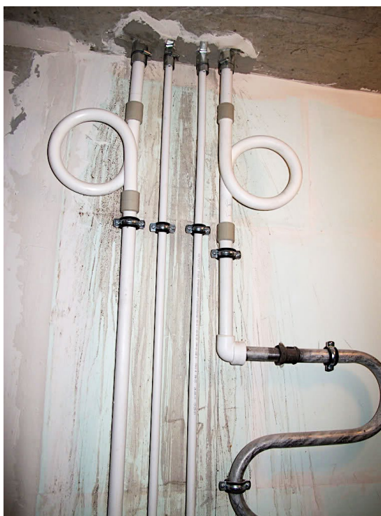
Обустройство компенсаторов удлинения труб при нагреве
